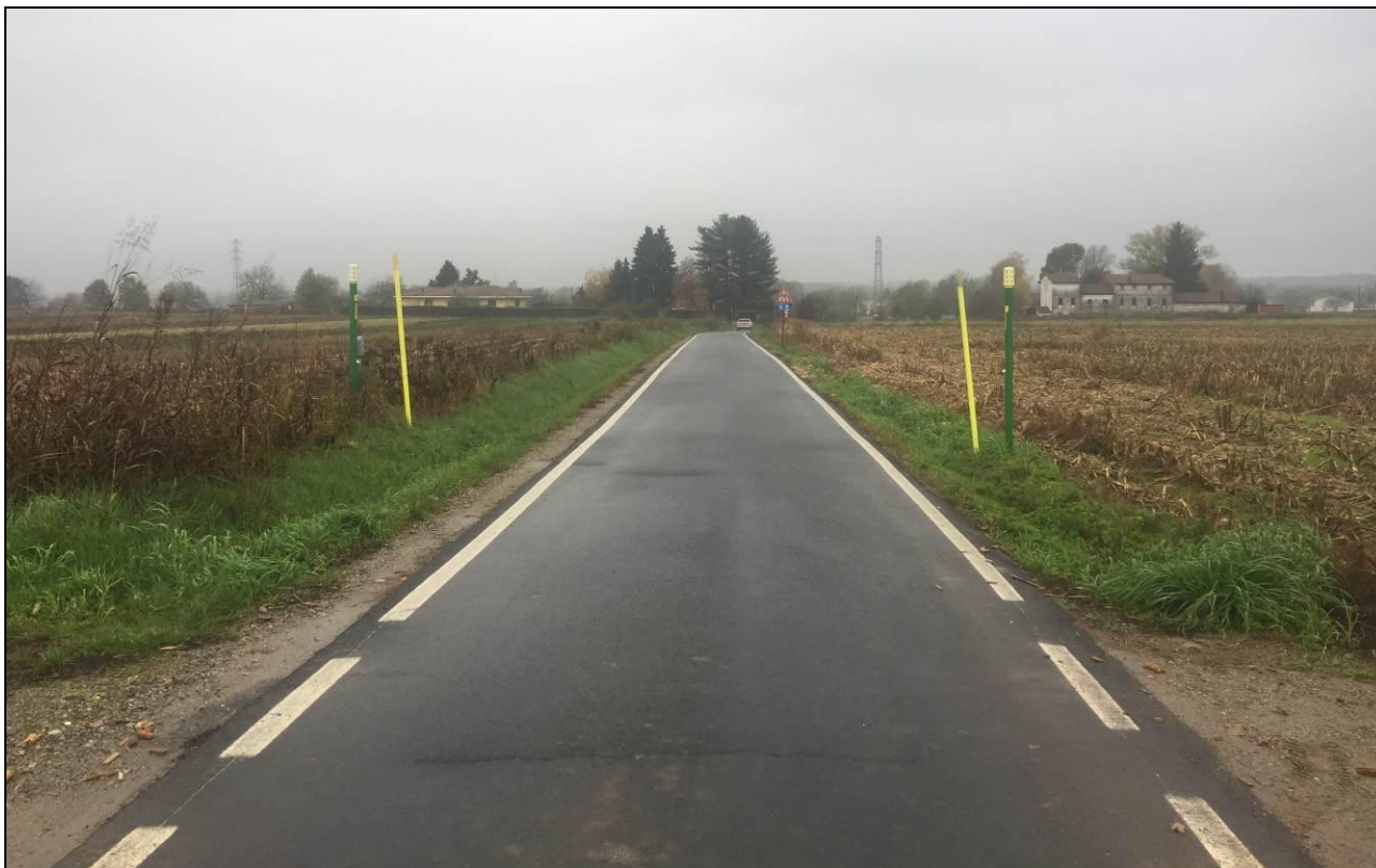
Tratto di strada con inizio fossi che saranno risagomati con realizzazione di trincea drenante sul fondo
